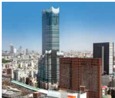
東急歌舞伎町タワー Tokyu Kabukicho Tower
